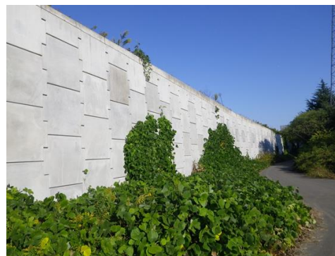
土工構造物の例：補強土壁
