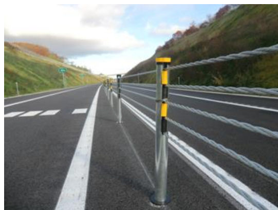
図-16.4 車線逸脱防止対策技術の導入例
