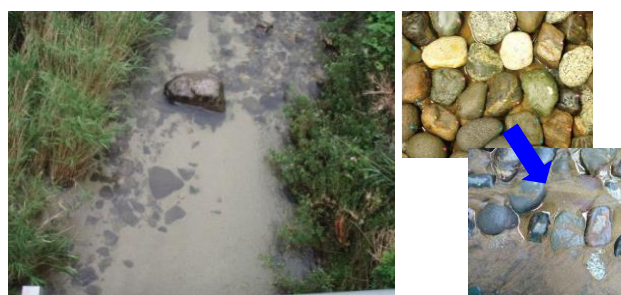
図-9.2 流域からの土砂の流出の影響を受けた河床
