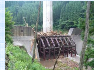
透過型砂防堰堤による土石流捕捉 (熊本県小国町)
