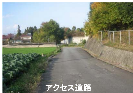
アクセス道路の幅員が狭く、大型車の通行に支障
