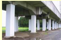
高架橋の耐震補強
