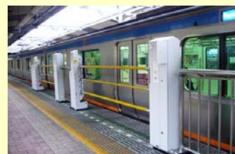
新たなタイプのホームドア (昇降バー式)
