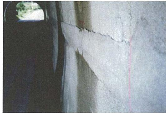
付写真-1.1.2 逆巻き工法の縦断方向打ち継目と化粧モルタルの施工状況の例
