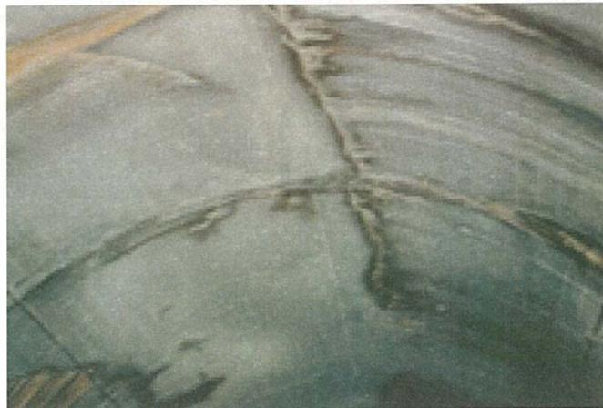
付写真-1.2.1 覆工の天端付近に発生した縦断方向のひび割れの例
