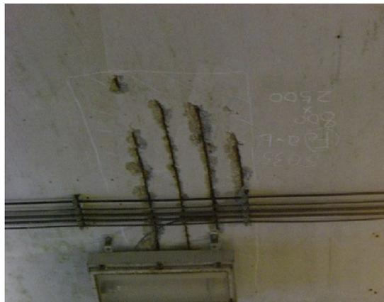
付写真-2.1.2 鋼材腐食の例
