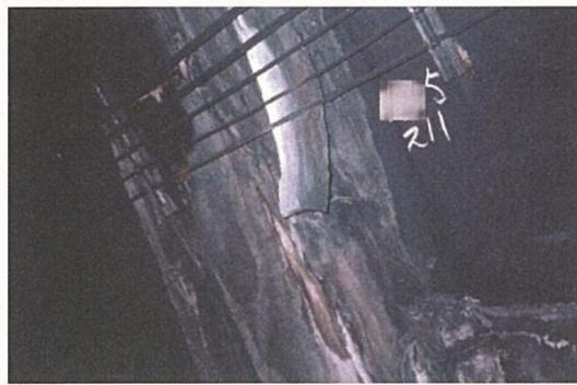
付写真-1.4.5 補修モルタルが劣化してはく離している例
