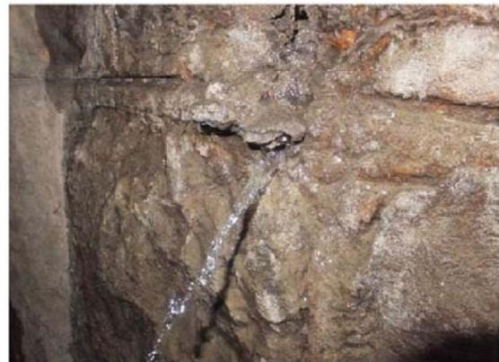
付写真-1.4.3 漏水（噴出）している例
