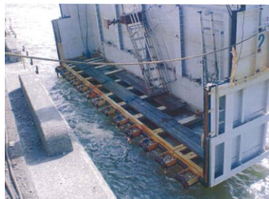
(a) 函体設置状況
