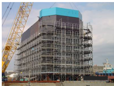
(a) 鋼製函体陸上仮組状況
