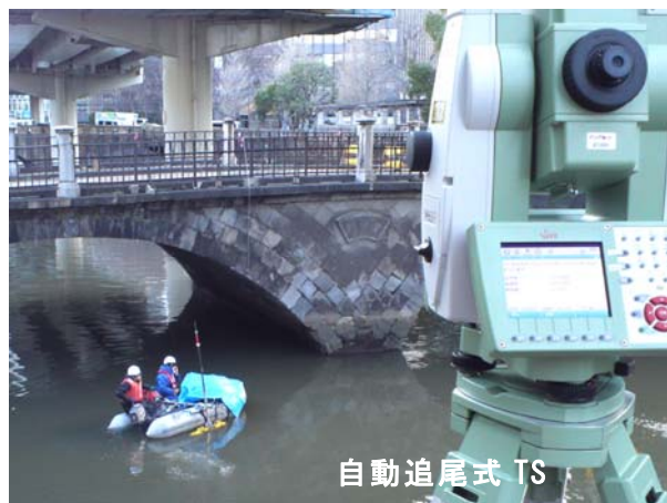
写真-2 橋梁下部での C3D 計測・調査
