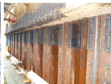
(b) 鋼矢板岸壁ドライアップ後
