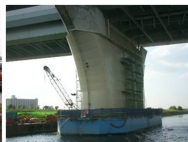
(c) 函体設置完了
