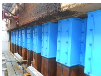
(c) 鋼矢板防食カバー設置後
