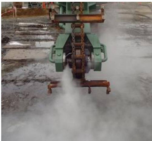
写真-3 改良材吐出状況 (交互連続吐出)
