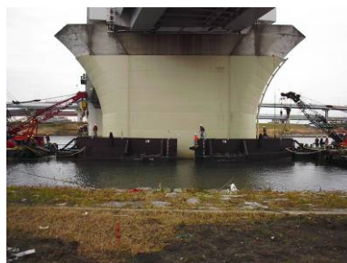
(b) 函体設置状況
