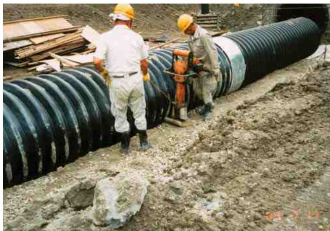
写真一2 ポリメタルスーパー施工状況(上・右)
