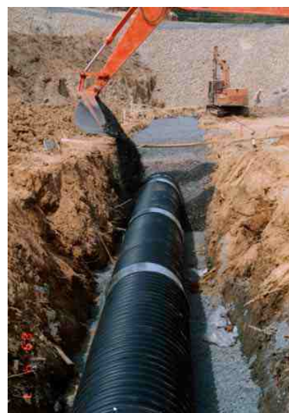
写真一2 ポリメタルスーパー施工状況(上・右)
