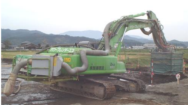
写真-1 施工状況
