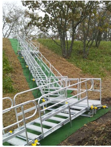
写真一 2 法面工事
