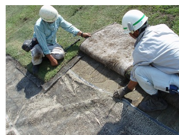
グリットシーバー敷設
