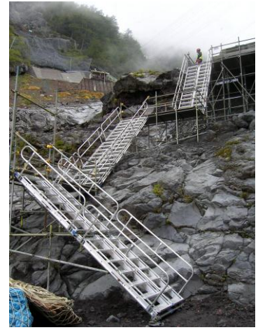
写真一 3 調査工事
