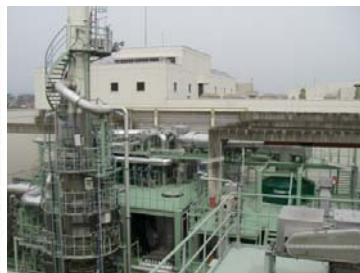
ターボ型流動焼却炉による 温室効果ガスの削減 (東京都下水道局)
