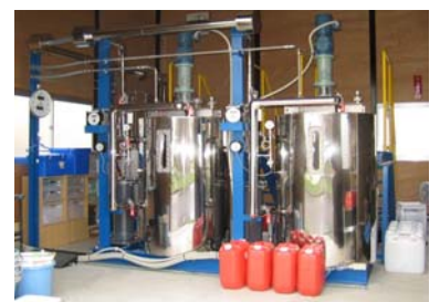
～バイオマス産業都市の構築を目指して～ 下水道汚泥と他バイオマスの混合消化 実証実験(新潟市)
