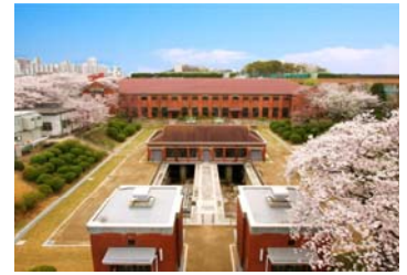
国指定重要文化財 『三河島汚水処分唧筒場施設』 ～わが国最初の近代下水道施設を公開 ・未来に継ぐ～(東京都下水道局)
