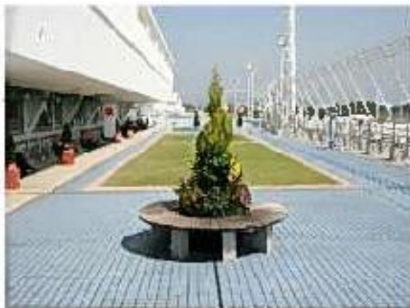
■展望デッキの屋上緑化
