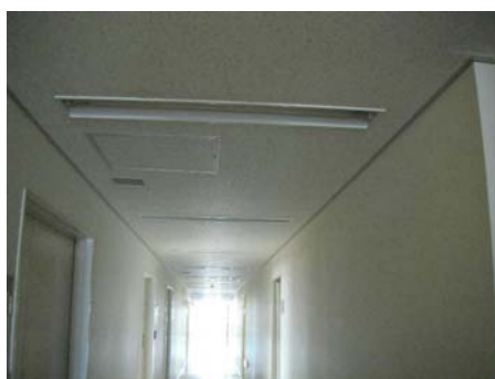
■不用照明の消灯 (庁舎)
