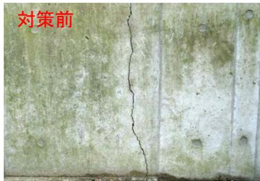
将来防護機能の低下が想定されるようなひび割れが生じている状態
