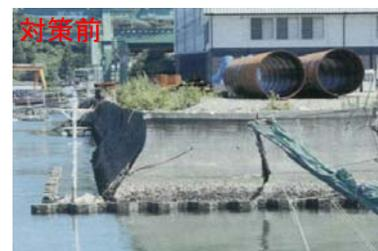
大きなひび割れが生じており、防護機能が明らかに確保されていない状態
