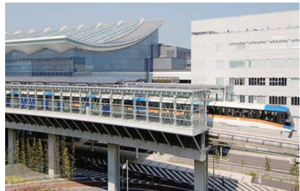
図表2-6-10 東京モノレール線羽田空港国際線ビル駅
