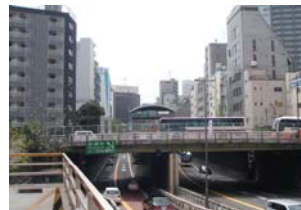
未活用の状態にある 首都高速道路の上部空間 諸外国と比べて広いインター チェンジ間隔(スマートICを除く)
