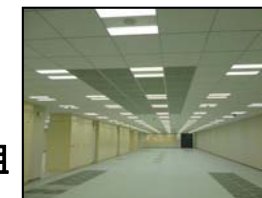
LED照明 〈気象庁清瀬庁舎〉
