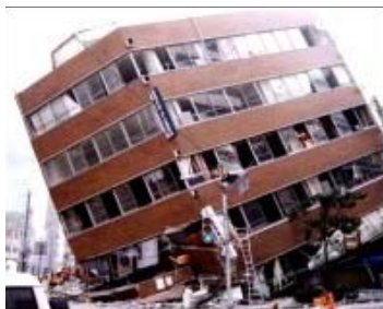
事務所ビル1、2階の崩壊
