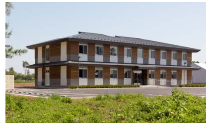
木造：横浜植物検疫所つくばほ場
