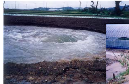
伊良湖サイホン漏水状況
