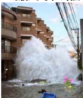
老朽化に起因する鋼管の破損による水の噴出
