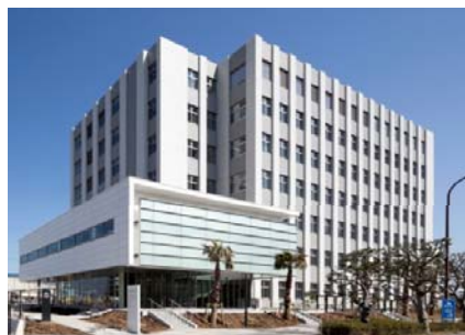
横須賀地方合同庁舎 (II類施設)
