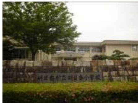
小学校の 整備
