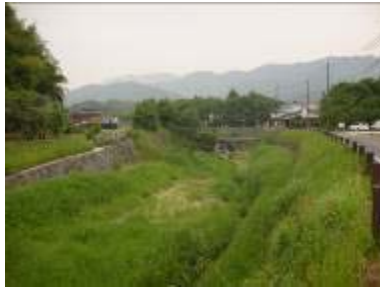
飛鳥川護岸整備
