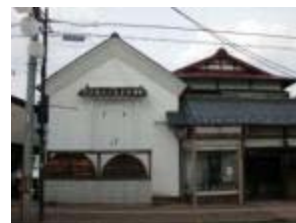
修理・修景後
