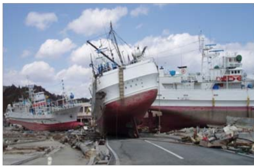
東日本大震災における船舶乗り上げ被害状況
