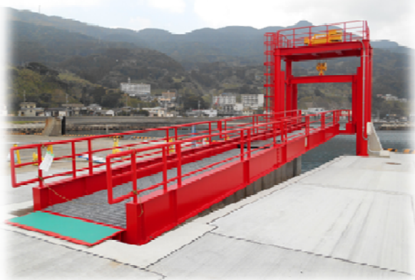
里港、長浜港 人道専用橋 (鹿児島県)
