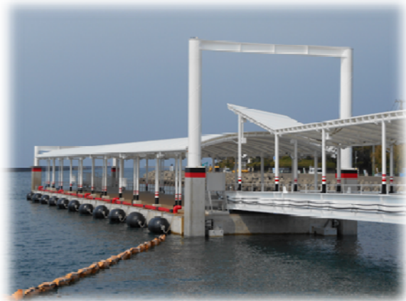
川内港 浮棧橋 (鹿児島県)
