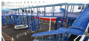
段差の解消(ボーディングブリッジ)
