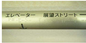
誘導ブロック(点字)の整備
