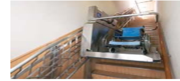
階段昇降装置の設置
