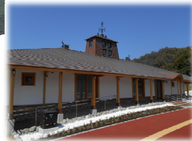
高速船ターミナル待合所 (薩摩川内市)
