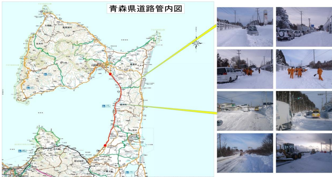
2月1日～2日にかけての暴風雪による国道279号雪害状況
