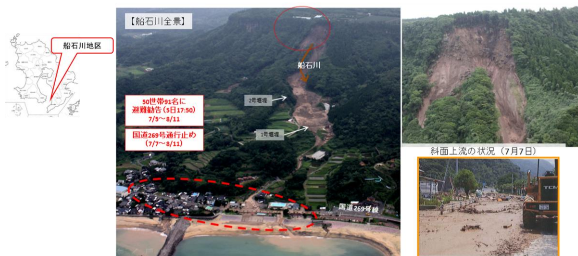
【図表 53：鹿児島県南大隅町で発生した土石流災害】
