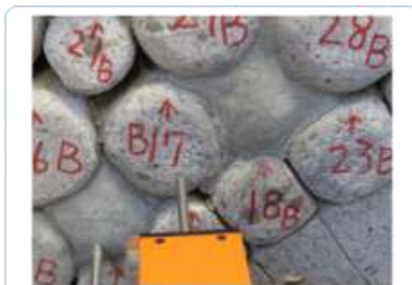
(a)欠損した部分のモルタル補修の状況
