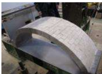
(a) アーチ輪石の組立て状況
