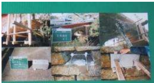
【写真 1-7 打上橋の修理作業風景（上）】
