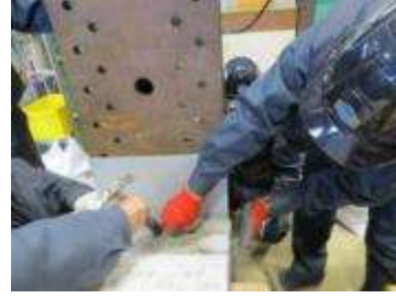
(c) 壁石内部の中詰め作業
