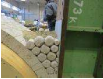
(d) アーチ支承部付近の壁石状況
