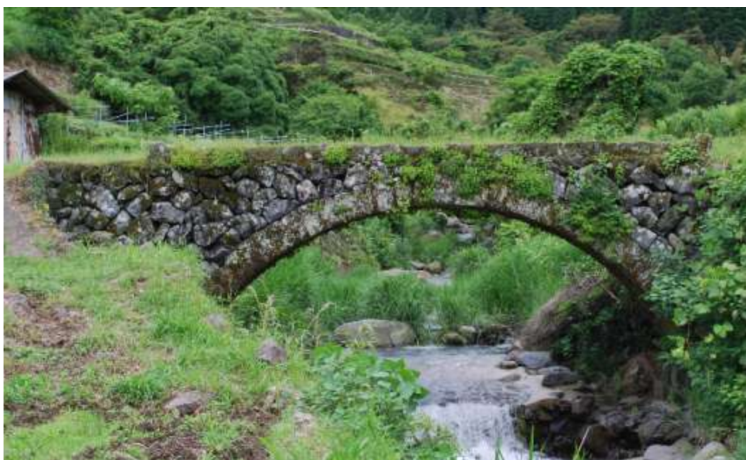
【写真 3-1 院内町の両合川橋】
