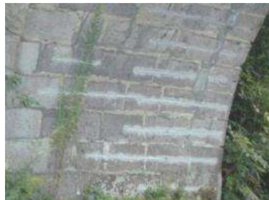
【写真 1-6 分寺橋の修理】
