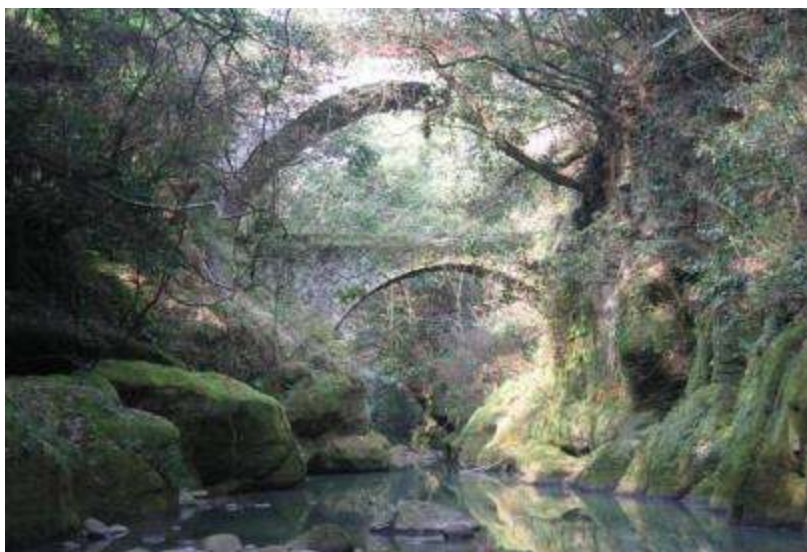
【写真1 打上橋(上)と打上水路橋(下)】
