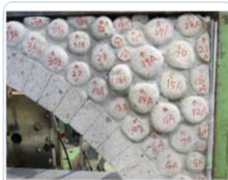
(b)孕み部分をモルタルで一体的に補修した
