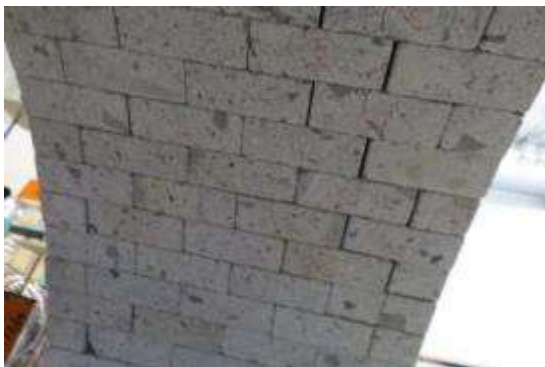
(a) アーチ輪石のひび割れ状況 (下部)
