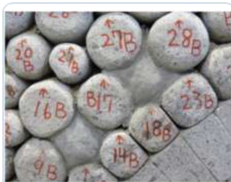
(a)欠損した部分をモルタルで局部的に補修した
