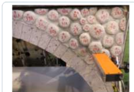
(b)孕み部分のモルタル補修の状況
