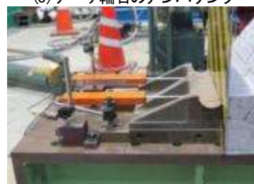
(e) アーチ支承部の設置状況
