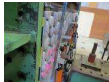
(m) 壁石の孕み状況 3
