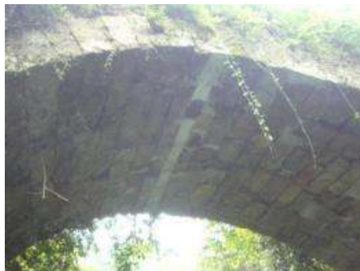
【写真 1-8 修理後の打上橋の輪石（右）】
