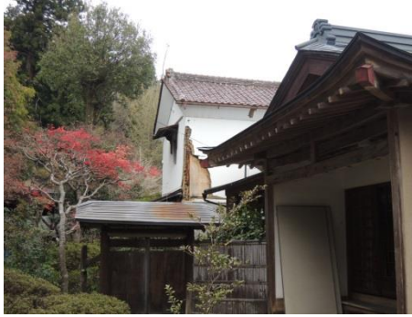
写真 3-3 修理前の土蔵
