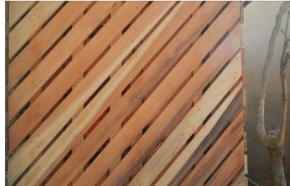
新工法：木摺下地
