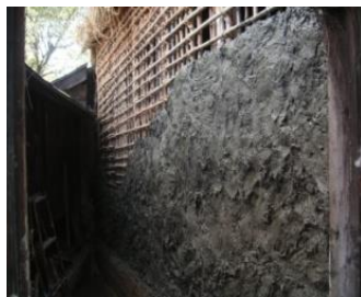
従来工法：竹小舞+壁土充填
