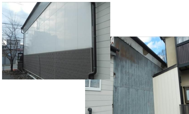
金属の板で施工された外壁
