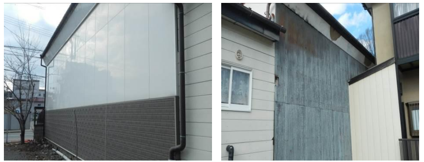
写真 3-6 カラー鉄板・波板による代替工法
