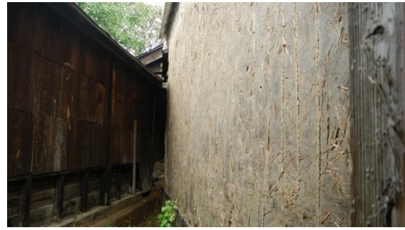
修理後1年経過した土蔵の大壁
