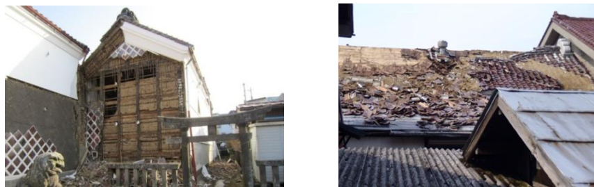
写真2-2 取り壊される土蔵の壁土（稲藁などを含む）
