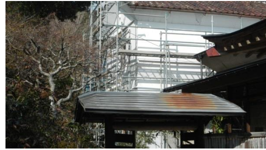
写真 3-4 新工法による修理完了の土蔵
