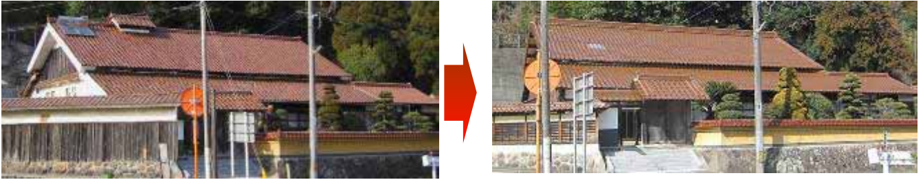
写真5 古瓦が新瓦に葺きかえられた事例
