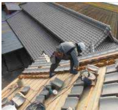
写真 21 土葺き(すじ葺き)
