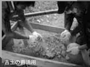
瓦土の改修作業
