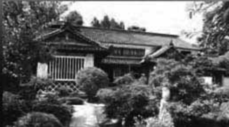
岡山県高梁市成羽町吹屋
