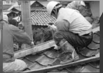
隅棟部分のノシ瓦施工
