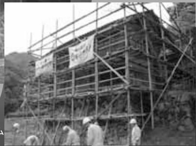
改修工事中の郷蔵
