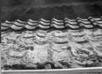
古瓦の撤去で表れた瓦土
