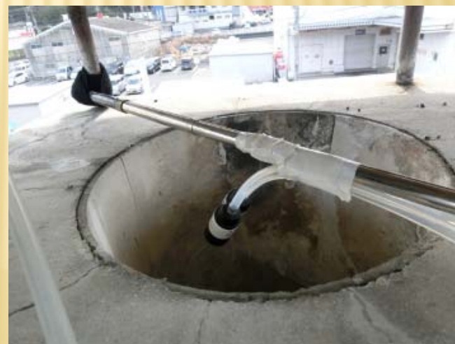
煙突頂部測定状況
