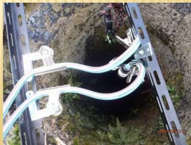
煙突頂部測定状況
