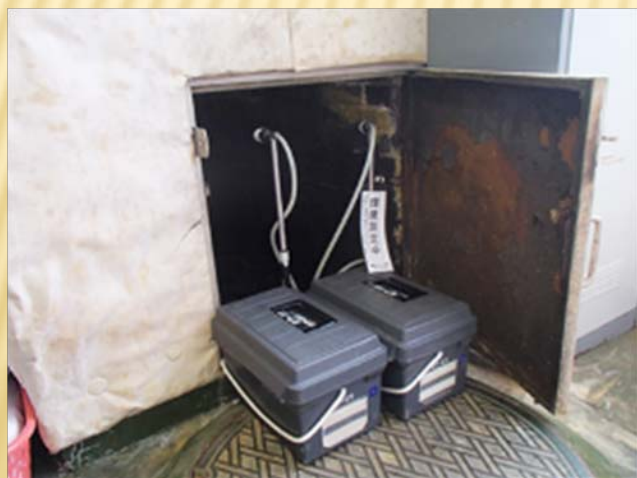
煙突点検口内測定状況
