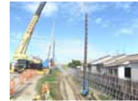
住宅地での施工状況
