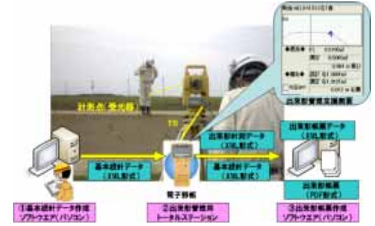
トータルステーション(TS)による出来形管理技術
