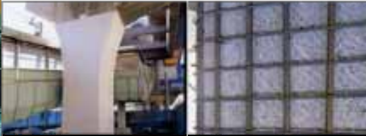
橋脚に鉄筋を追加
