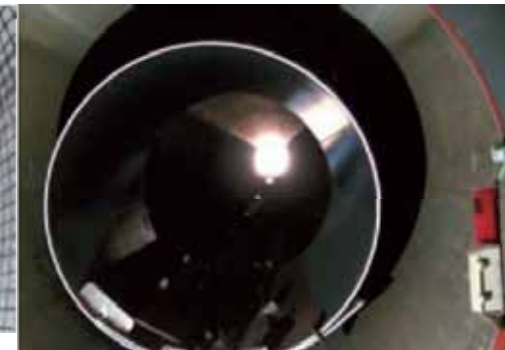
サイホン内に鋼管を挿入し補強
