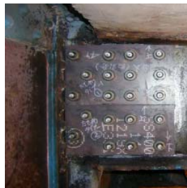
H21修繕後 (主桁修繕)
