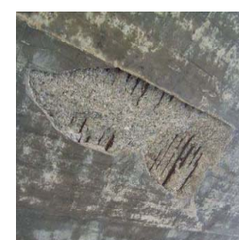
H19損傷状況 (剥離・鉄筋露出)
