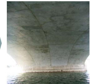
H19修繕後 (断面修復)
