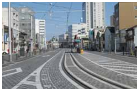
〔基幹事業〕走行路面、架線、停留場
