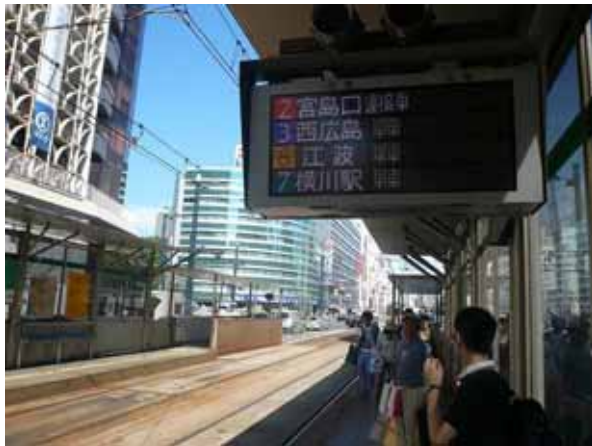
広島電鉄 電停内に設けられた電車接近掲示板
