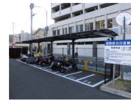
安全性の確保した駐車場整備
