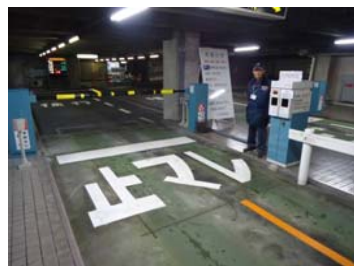
2本バーゲートの設置
