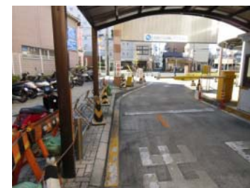
出庫ゲートバーを短くカットし、自動二輪車が通ることができるよう改修(右)
