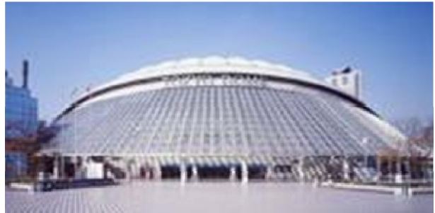
出典：株式会社東京ドームHPより
