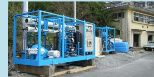
海水淡水化装置設置状況
