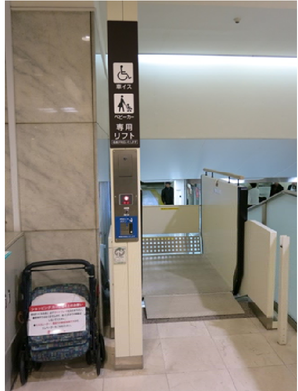
図 階段昇降機の利用案内（上段側） （商業施設）
