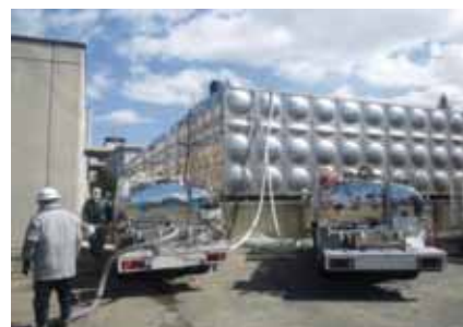
福島市内の基幹病院への応急給水活動 (長崎市上下水道局より資料提供)
