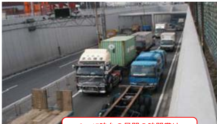
《第二航路海底トンネルの渋滞状況》
