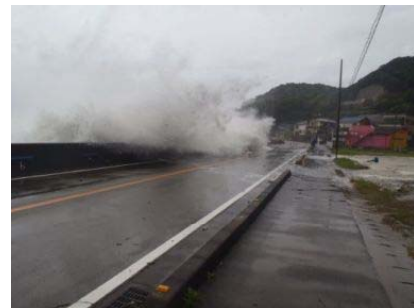
▲並行する国道42号 【台風による越波状況】
