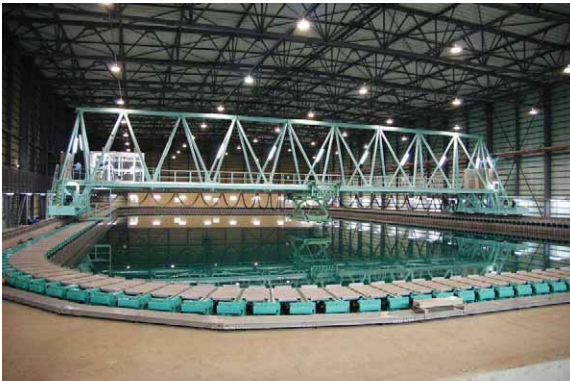
事故発生前の内観
