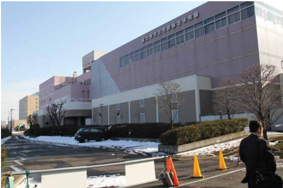
事故後の外観
