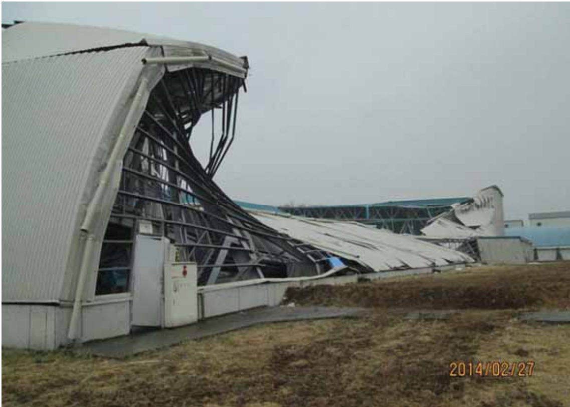
外観（北東側より（右側が北、手前が東））
