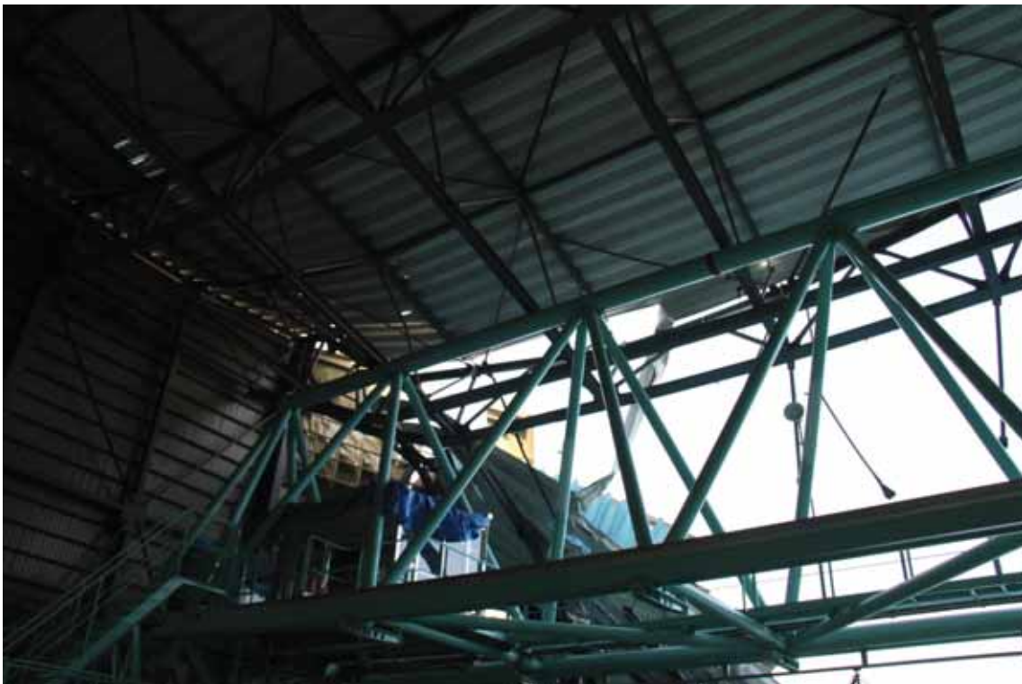
実験装置（トラス状構造物）に引っかかった屋根梁（建屋西端側）
