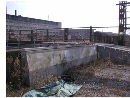
車の利用のある陸閘は廃止し、通行可能なスロープを設置した事例(種崎地区)
