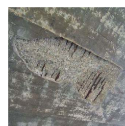
H19損傷状況 (剥離・鉄筋露出)
