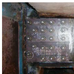
H21修繕後 (主桁修繕)
