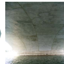
H19修繕後 (断面修復)
