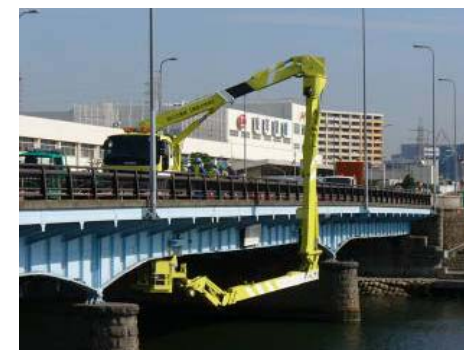
橋梁点検車を使用した点検の様子
