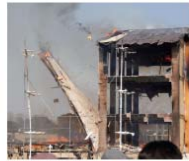
96分：防火壁倒壊
