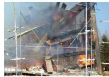
122分：軸組東部分倒壊
