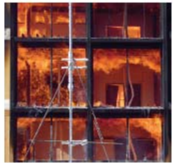
42分：防火扉状況
