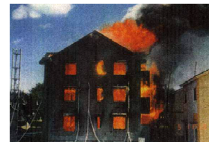
平成8年の実大火災実験の火災最盛期の様子
