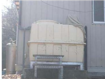
写真② 雨水タンク1
