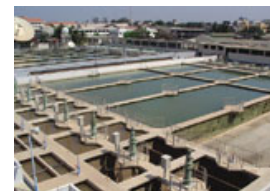
上水道施設の洗殿池 プンペン市上水道整備事業 (カンボジア) 出典: 外務省HP
