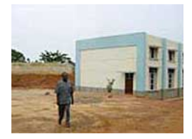
ブースターポンプステーション タンザニア国首都圏周辺地域給水計画 (タンザニア) 出典: JICA HP
