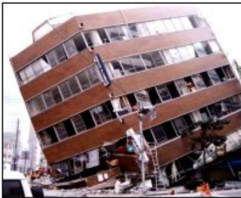
事務所ビル1, 2階の崩壊
