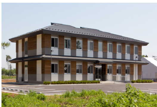
横浜植物防疫所つくばほ場(事務・検査棟)
