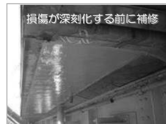
橋梁補修後の状況
