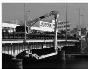
橋梁点検車による点検
