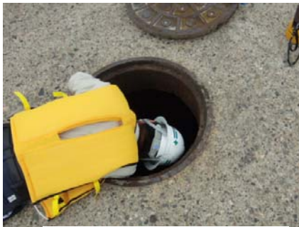
点検孔からの確認
