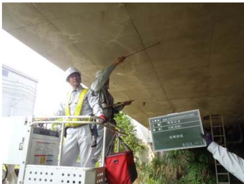
臨港交通施設（橋梁）打音点検
