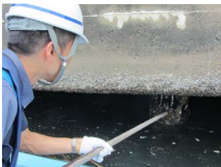
鋼材の防食確認
