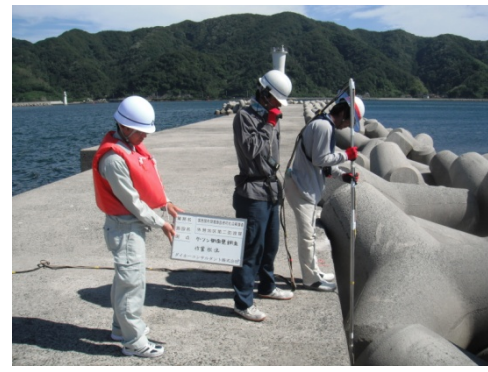
ケーソン側壁調査
