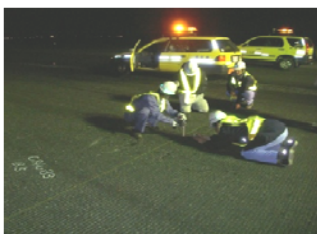
(基本施設点検実施状況)
