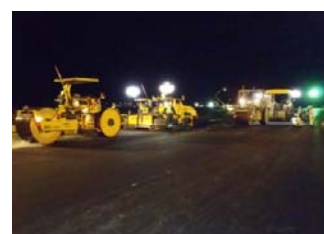
(老朽化した滑走路舗装の改良)
