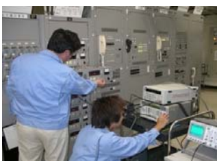
(航空保安施設点検実施状況)
