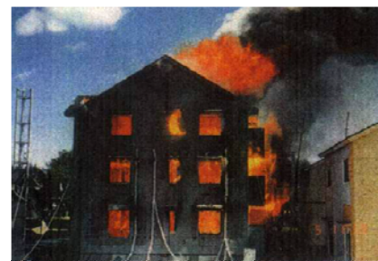
平成8年の実大火災実験の火災最盛期の様子
