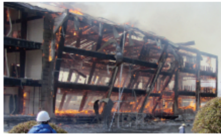
75分：軸組中央部分倒壊
