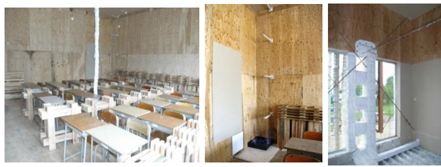
写真 1階内部 写真 火源近傍 写真 2階内部
