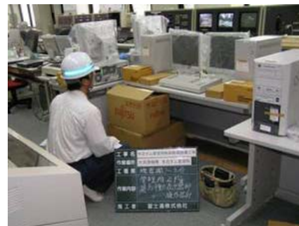
ダム操作機器の更新
