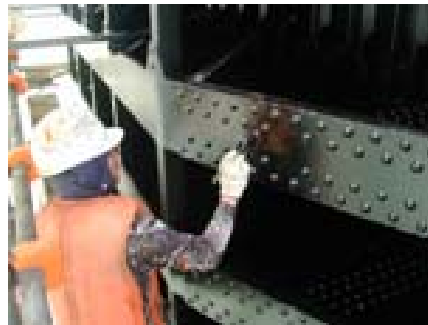
ダムゲートの塗装
