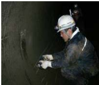
電磁誘導法の測定状況
