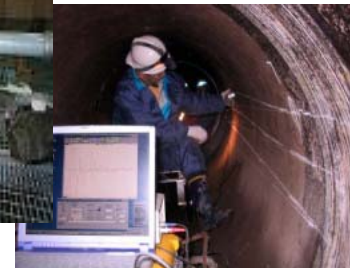
水路内面から調査
