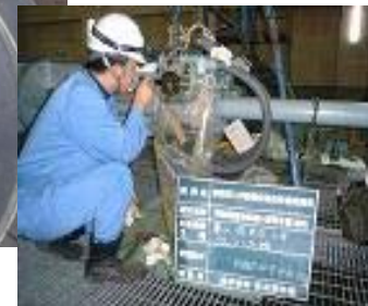
設備の分解整備
