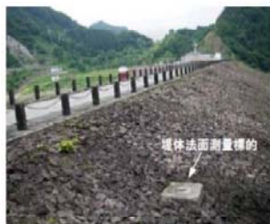
フィルダム堤体 下流側の可動標的
