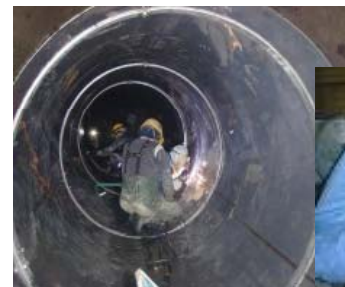
漏水した管の補修状況
