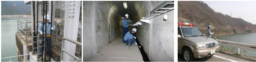
ゲート設備等の点検
