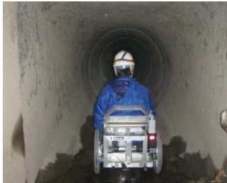
管内走行状況
