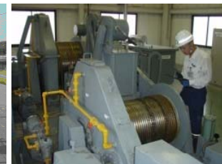
ゲート設備等の点検
