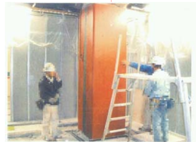
施工写真 ( 鋼板建込み )
