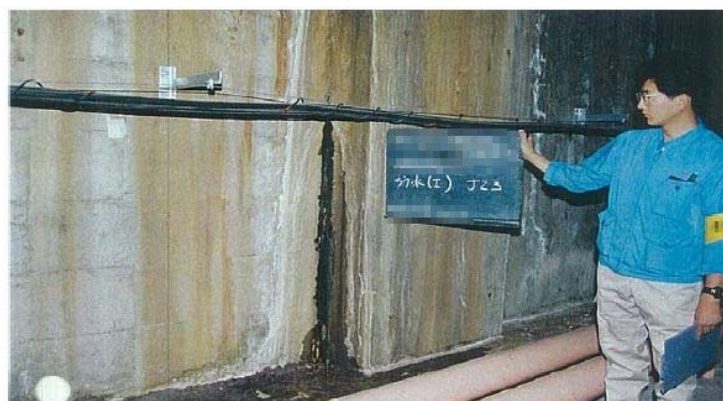
写真 3-2-3 漏水調査状況
