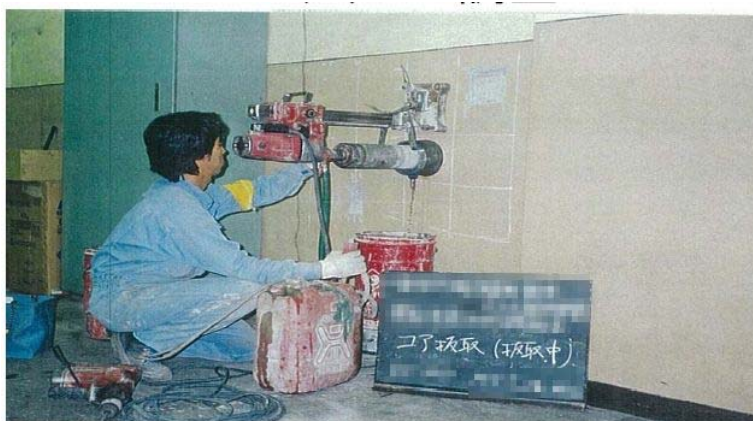
写真 3-2-4 コンクリートコア(試料)採取状況
