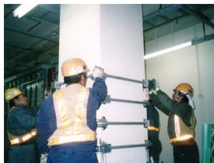
コーナー支持材設置、鋼材締め付け
