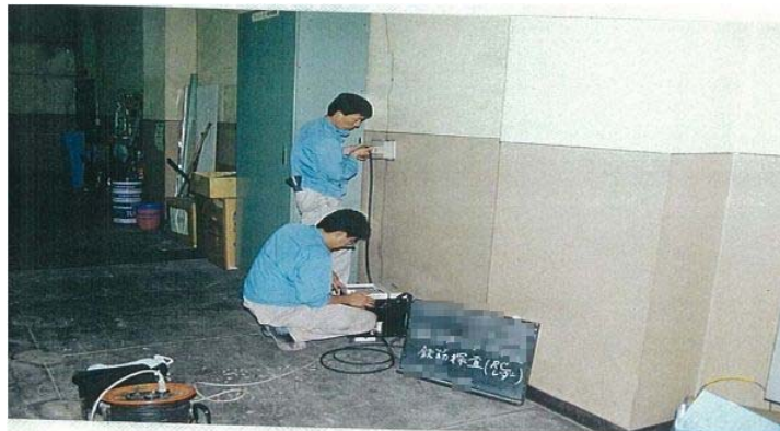
写真 3-2-9 電磁波による鉄筋調査
