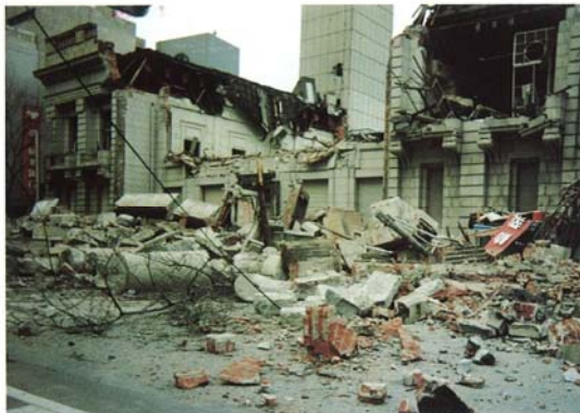
写真1 中央区栄町通 5) バラバラになって道路に散乱した石材
