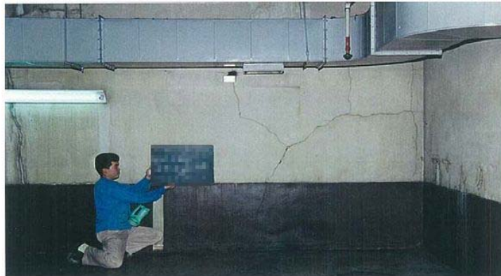
写真 3-2-1 ひび割れ調査状況
