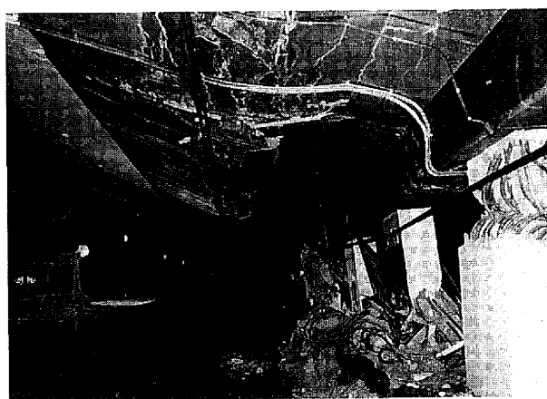
写真 2-1-3 中柱の圧壊及び上床版の陥没（Aゾーン）
