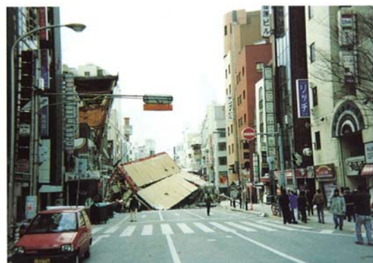
写真2 中央区下山手通 5) 倒れて道路をふさいだビル
