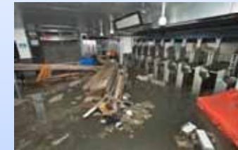
地下鉄駅の浸水状況 ©MTA
