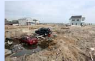
沿岸部の家屋損壊状況 ©USACE
