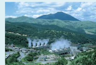
八丁原地熱発電所 (出力110,000kW)
