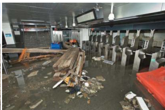
地下鉄駅の浸水状況 ©MTA
