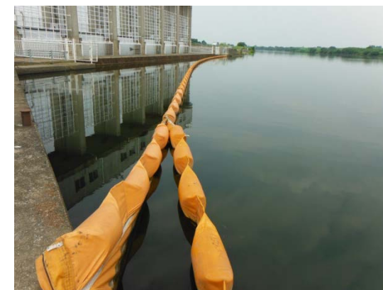
オイルフェンス設置(秋ヶ瀬取水口)
