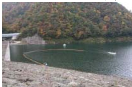
毒物が投入された周囲にオイルフェンス設置
