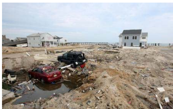
沿岸部の家屋損壊状況 ©USACE
