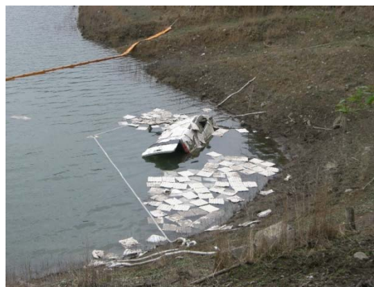
オイルマット設置(日吉ダム)
