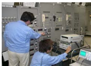
(航空保安施設点検実施状況)
