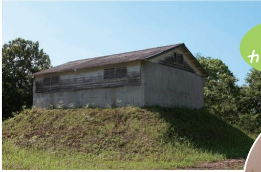
石室(いしむろ)(第一変化計室)。大正元年建造。平成7年まで使用していた施設。本体はかまぼこ型の石造りで温度変化を防ぐために全体に土盛り(どもり)している。現在は展示施設となっている。
